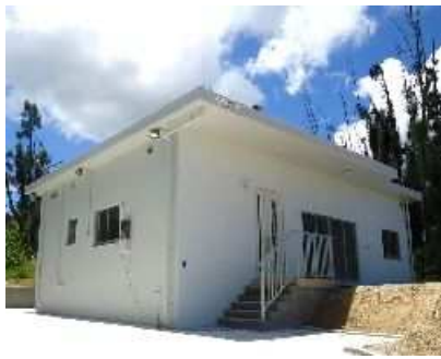
恩納村地内 総床面積 107.10m 2 営業担当:高田知寿 現場担当:宮城 敏
